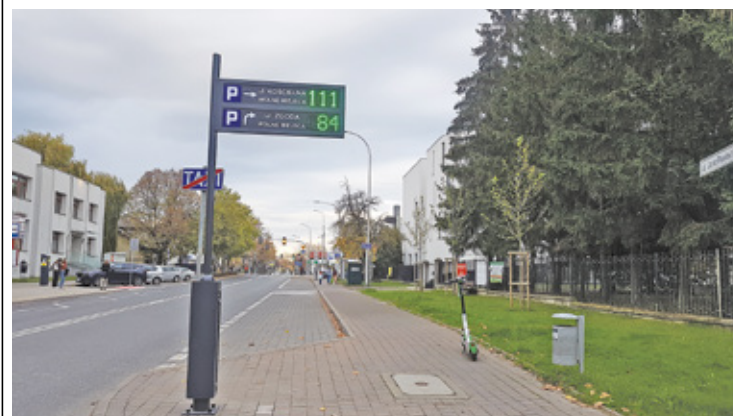
W ramach inteligentnego systemu monitoringu i analizy wolnych miejsc parkingowych zamontowano 330 czujników parkingowych oraz 7 elektronicznych tablic informacyjnych
