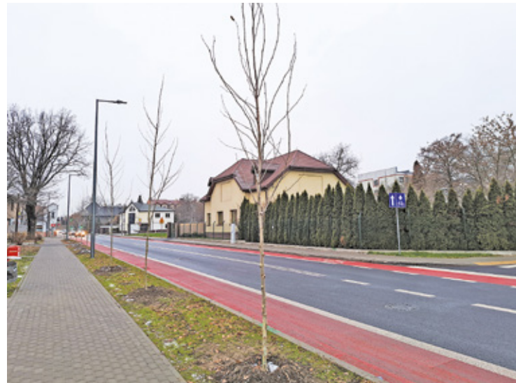
Wzdłuż ul. Pod Bateriami posadzono 50 lip drobnolistnych
