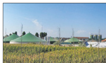
|| Góra Kalwaria - Wybudują biogazownię s. 2
