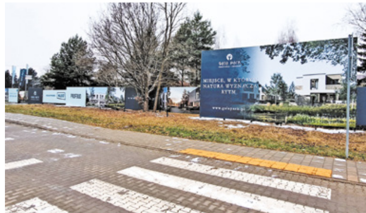
Ogrodzenie placu budowy pokryte zostało reklamą budowanego osiedla
