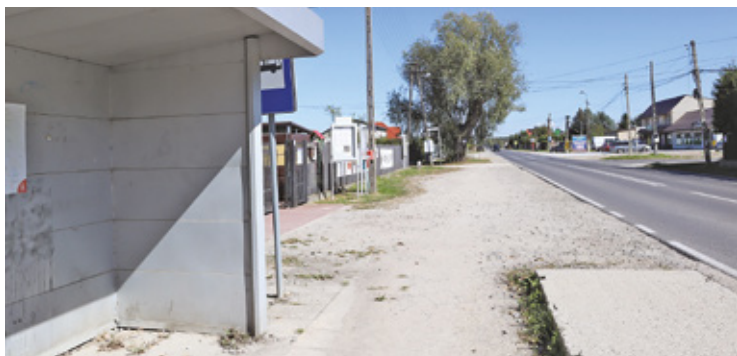
Przejście na przystanek, do sklepu czy klubu kultury było bardzo niebezpieczne
