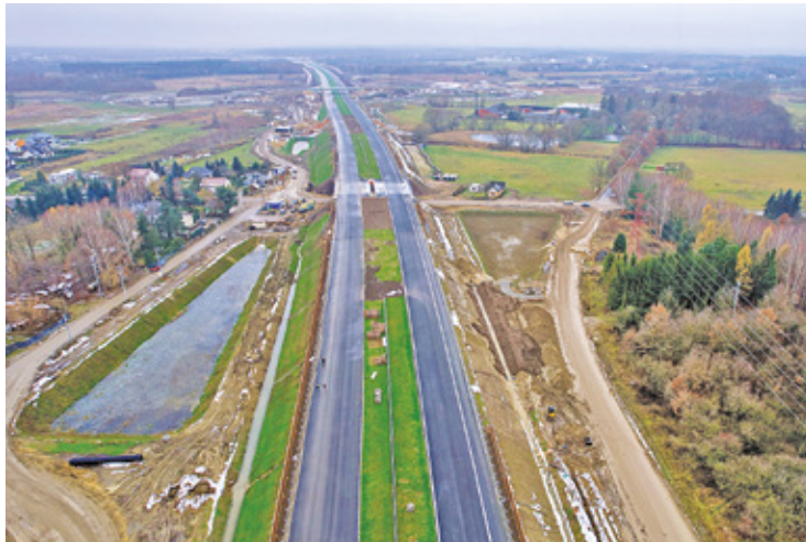
Na ciągu głównym została już wykonana nawierzchnia
