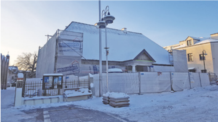
Remont zabytkowego obiektu, który wybudowano ok. 1800 roku, trwa od kilku lat
