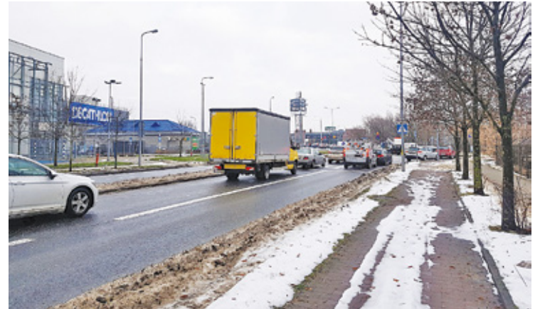
Mieszkańcy wskazują, że rondo na rogu ul. Puławskiej oraz Energetycznej i tak jest już zakorkowane
