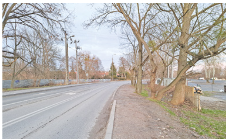
Istniejący odcinek chodnika po południowej stronie ul. Wojska Polskiego zostanie przedłużony do wejścia na targ
