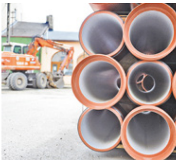
W ramach inwestycji przebudowana zostanie instalacja sanitarna
