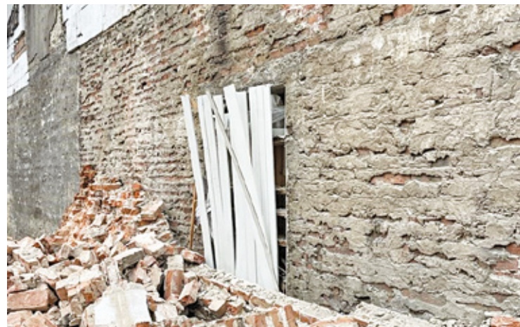
Rozbiórka ściany graniczącej z domem pani Ewy
