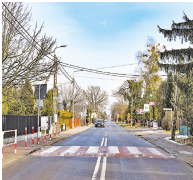
Ulica Krasickiego w Nowej Iwicznej zostanie przebudowana
