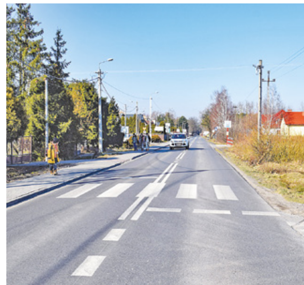
W tym roku będziemy kontynuować przebudowę drogi w Ustanowie
