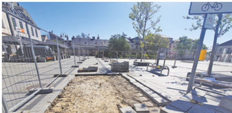
Prace remontowe na pl. Piłsudskiego i skwerze Jana Pawła II kosztować mają blisko 1,5 mln złotych
