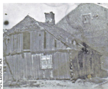
Dom Sikorskich ściana północna i przylegający do niej drewniak
