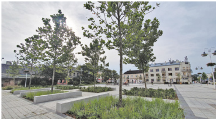
Nasadzenia pośród terenu utwardzonego oraz licznych elementów sieci i mediów, wymagały zastosowania ekranów ochronnych, systemu antykompresyjnego oraz systemu napowietrzająco-nawadniającego
