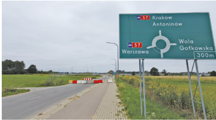
Możliwe, że termin otwarcia węzła zostanie podany na początku września
