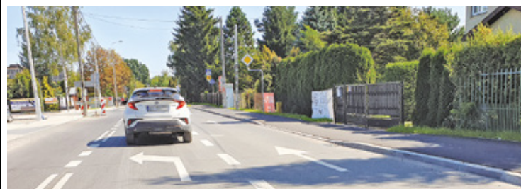
Starostwo powiatowe rozpoczęło przebudowę ulicy Krasickiego pod koniec kwietnia tego roku i realizuje remont trzykilometrowego odcinka etapami
