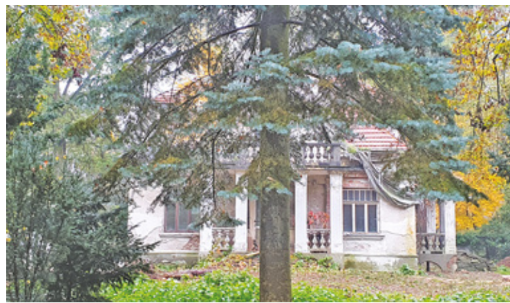
Willa Jast wymaga generalnego remontu, najpierw konieczne jest zabezpieczenie dachu
