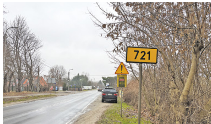
Na pięciokilometrowym odcinku, droga zyska nową nawierzchnię i oświetlenie. Pojawią się także chodnik, ścieżka rowerowa i przejścia dla pieszych
