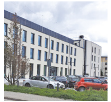
Powiat kontynuować będzie prace w ramach modernizacji ulicy Sienkiewicza. Inwestycji byłoby zapewne więcej, gdyby nie konieczność przekazania w ramach Janosikowego 70 mln zł
