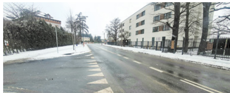
Wznowienie prac drogowych nastąpi na wiosnę
