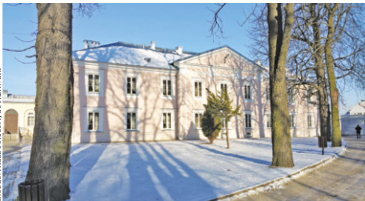
Remont budynków na terenie DPS trwał przez prawie dwa lata. Prace były prowadzone pod nadzorem konserwatora zabytków
