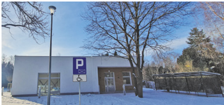
Umowny termin zakończenia robót budowlanych wyznaczono na początek lutego
