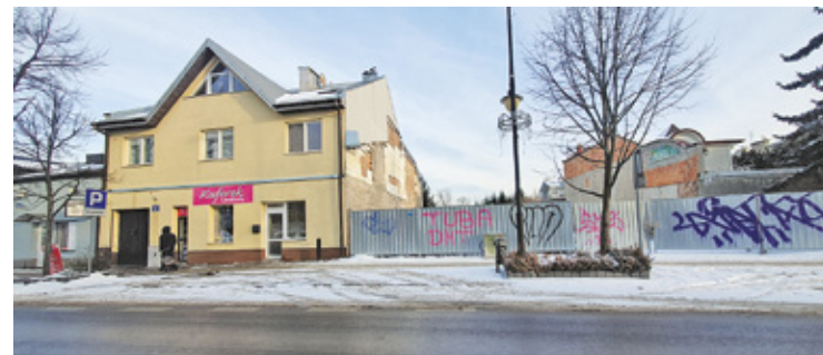
Inwestor planuje 100 mieszkań i garaże podziemne, ale póki co nie ma pozwolenia na budowę
