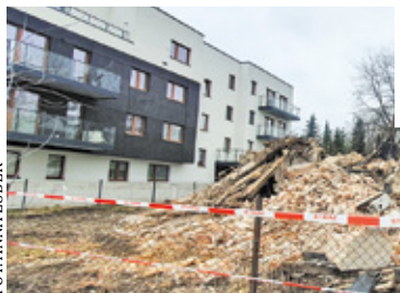
Rozbiórka domu drogowskazu w marcu 2024 r.
