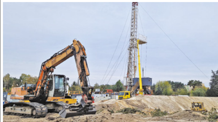
Na ponad 1,5-hektarowe działce prowadzone mają być odwierty geotermalne. Na zdjęciu tego typu prace w Otwocku
