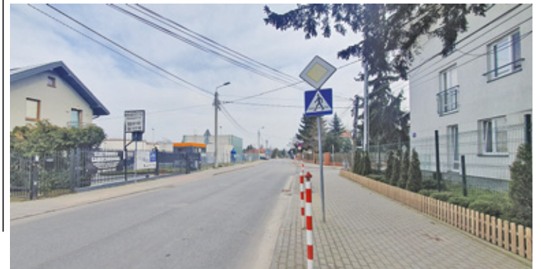
Miasto czeka na wyłonienie wykonawcy bieżących prac drogowych, wówczas pojawią się i progi, i pasy
