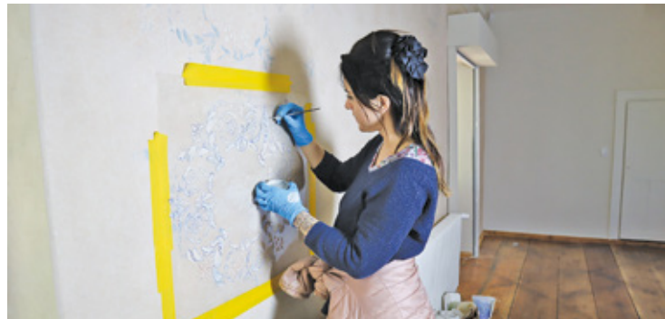
Przez najbliższe miesiące w dworku trwać będą prace przy freskach
