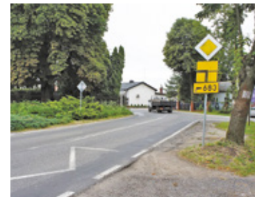
Rozbudowa układu komunikacyjnego w Sobikowie obejmie około dwukilometrowy odcinek drogi
