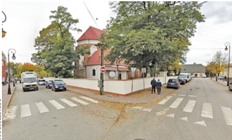
Obecnie z braku miejsc parkingowych kierowcy parkują na chodnikach
