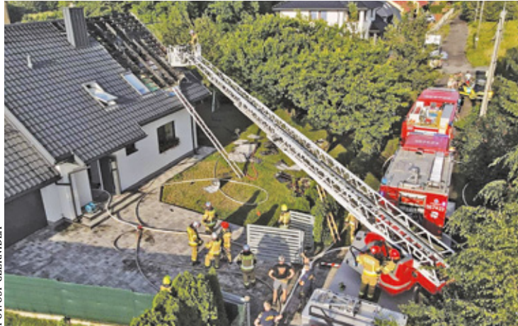
Dom wymaga generalnego remontu oraz częściowej odbudowy
