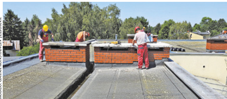
Prace remontowe rozpoczęły się jeszcze przed końcem roku szkolnego
