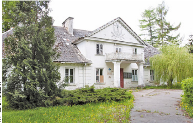
Brak remontu dachu skutkowałoby popadnięciem budynku w ruinę
