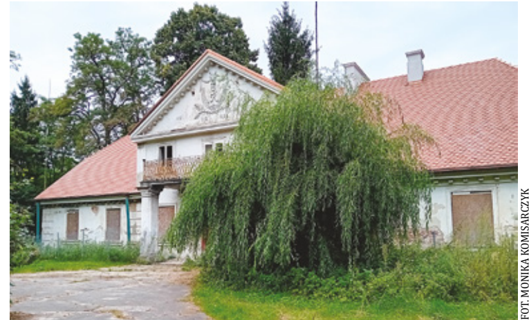
Nowy dach już jest. Teraz kolej na elewację
