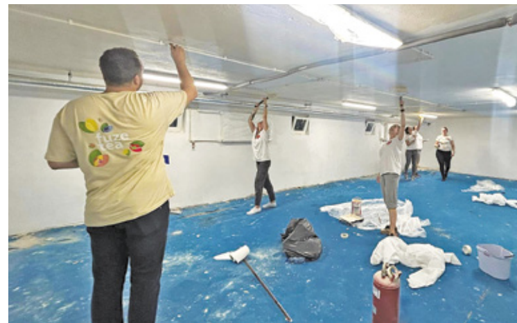
Nad modernizacją sali pracują rodzice i wolontariusze
