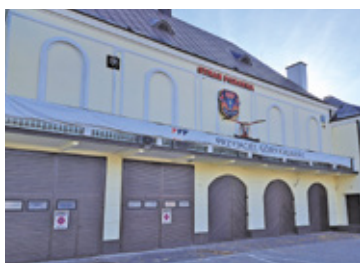
Chociaż na zewnątrz budynku tego nie widać, to trwa aktualnie ocieplanie sali kinowej
