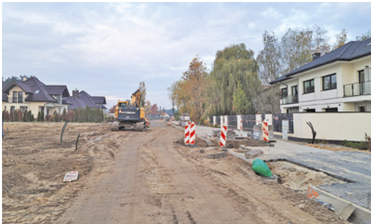
Według umowy termin zakończenia prac to 24 kwietnia 2025 r.
