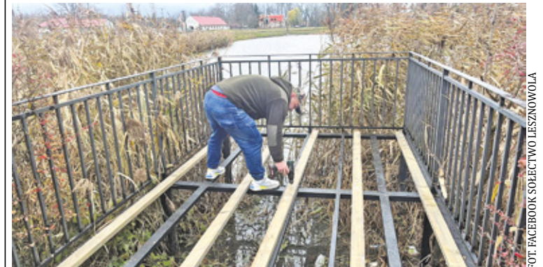
W sierpniu pomost został zniszczony, gdy wprowadzono na niego... konia, a deski nie wytrzymały ciężaru zwierzęcia
