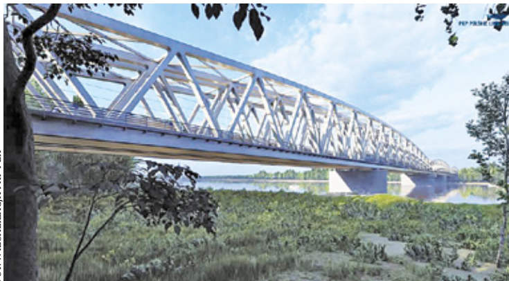
Prace przy nowym moście mają być realizowane w latach 2025-2028
