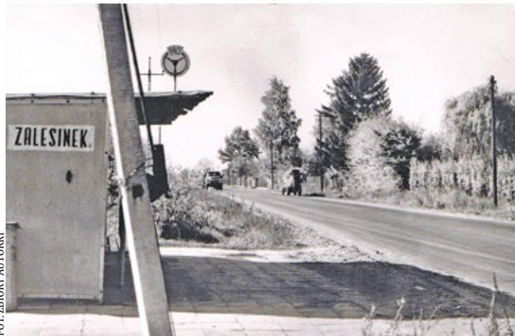
Zalesinek, przystanek autobusowy w latach 60.
