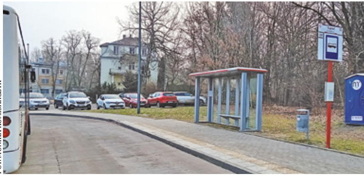
Wiaty przystankowa została już zainstalowana
