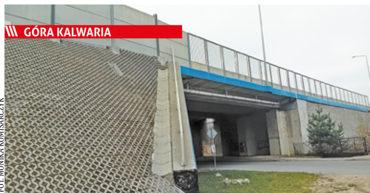
FOT. MONIKA KOMISARCZYK Z wykonanej analizy wynika, że eksploatacja obwodnicy „nie powoduje przekroczeń dopuszczalnych norm hałasu w środowisku”
