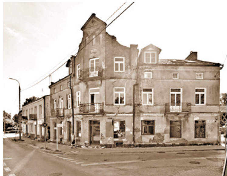
Dom Poncyliuszów tuż przed remontem, po prawej stronie budynku, od ul. Czajewicza widoczne okna restauracji pani Lange
