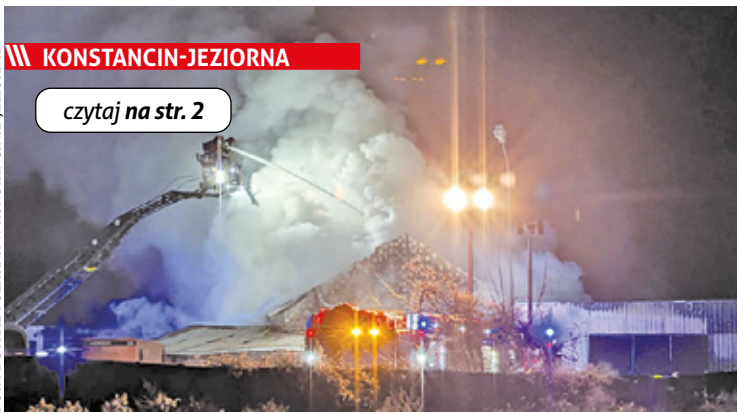
Akcję ratunkową utrudniał zawalony dach
