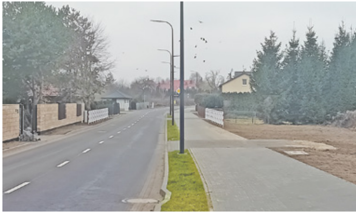
Ulica Fabryczna z wąskiej polnej drogi, jaką była jeszcze kilkanaście lat temu, przeobraziła się w piękną arterię z nową nawierzchnią
