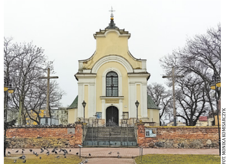
Prace są realizowane w ramach Rządowego Programu Odbudowy Zabytków
