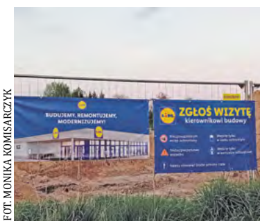
Aktualnie na placu budowy trwają prace ziemne
