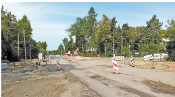
Remont drogi DW721
