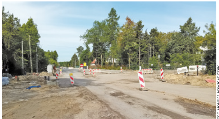
Remont drogi DW721
