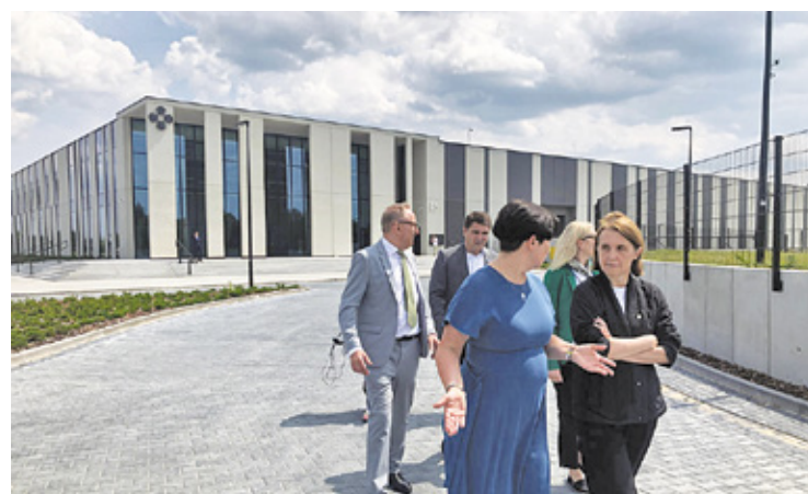
Zakończył się pierwszy etap budowy budynku, którego łączna powierzchnia 21 tys. m 2 mieści część magazynową (15 tys. m 2 ), pracownice konserwatorskie, fotograficzne i digitalizacyjne oraz pomieszczenia edukacyjno-konferencyjne
