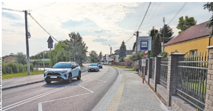
Modernizacja objęła odcinek pomiędzy ulicami Postępu i Szkolną
