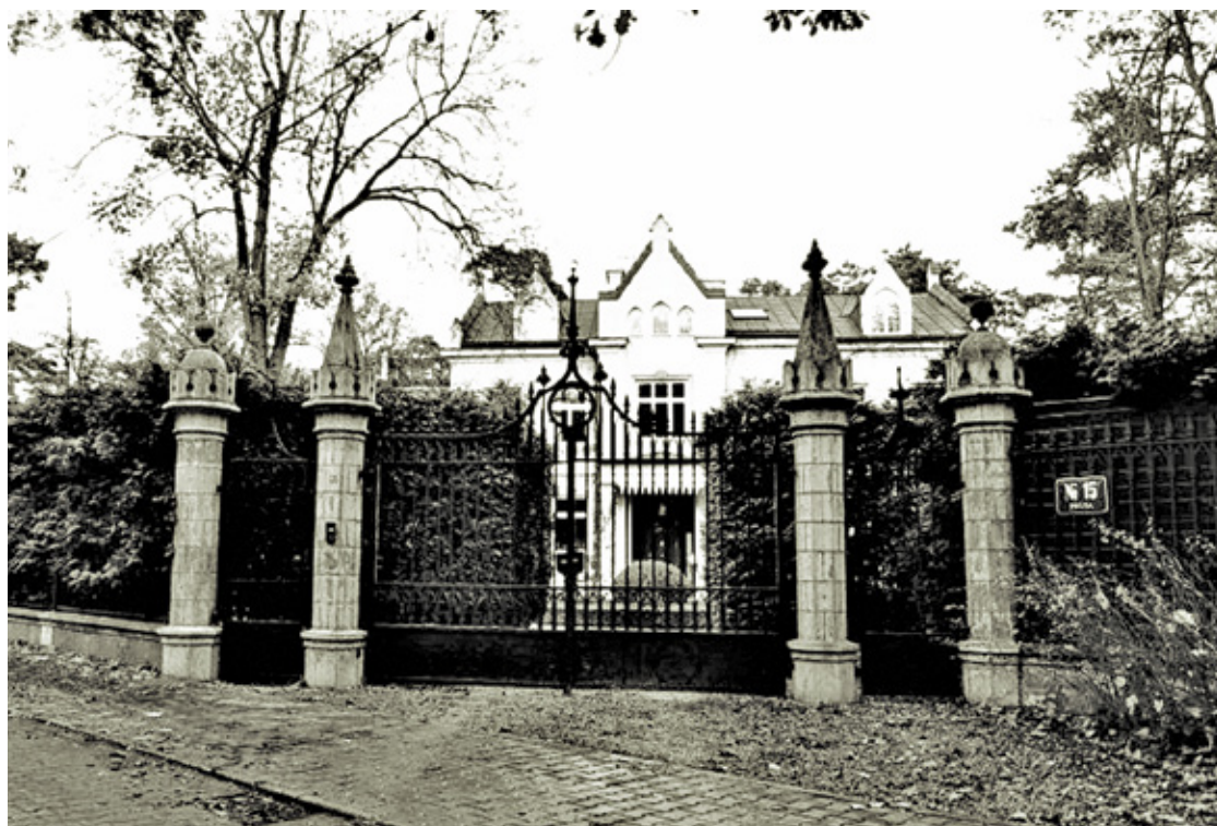
Odrestaurowany pensjonat Danuty Szczerskiej przy ul. Prusa 15. w Skolimowie
