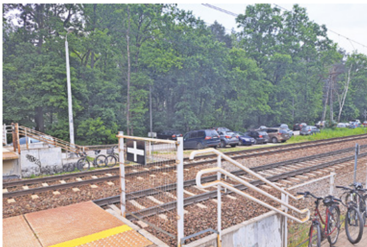
Gmina planuje kompleksową modernizację całego otoczenia stacji
