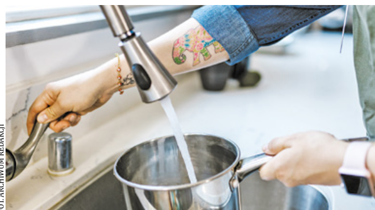
Zmiana cen to efekt rosnących kosztów utrzymania i modernizacji infrastruktury wodociągowo-kanalizacyjnej
