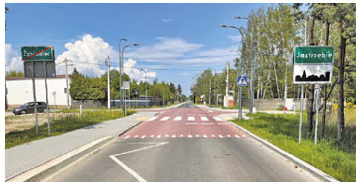
Przebudowa ulicy Ptaków Leśnych była jedną z największych inwestycji drogowych ostatnich lat na terenie gminy Piaseczno.
