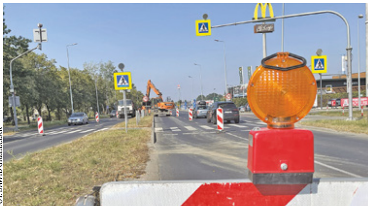
W ramach inwestycji powstanie również nowy odcinek ulicy Wojska Polskiego, który połączy ul. Puławską z Okulickiego. To znacząco odciąży ruch w tej części miasta
