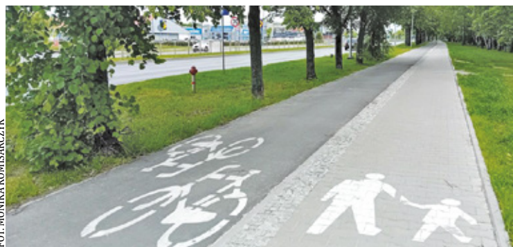
Ścieżka wzdłuż ul. Okulickiego od Wojska Polskiego do Powstańców Warszawy
