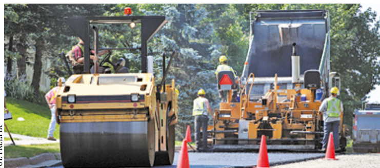
Modernizacja obejmie nie tylko jezdnie, ale również budowę kanalizacji deszczowej, oświetlenia, chodników i tras rowerowych
