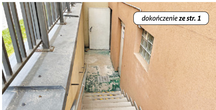
Podczas inwentaryzacji przeprowadzonej przez Państwową Straż Pożarną weryfikowano obiekty znajdujące się na poziomie minus jeden – czyli piwnice, podziemne garaże itd.
