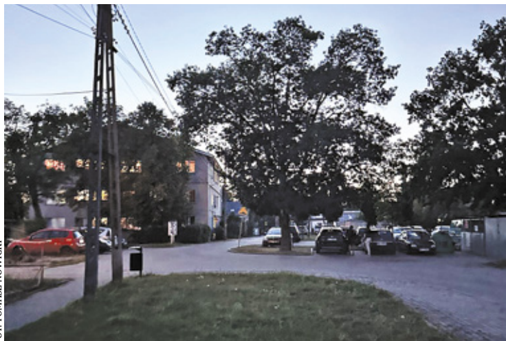
Na odcinku od ul. Julianowskiej w Piasecznie do ul. Skolimowskiej w Konstancinie-Jeziornie zostaną zamontowane nowe szafy oświetleniowe
