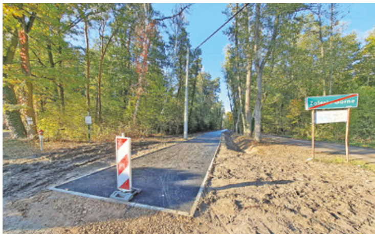
Budowa ścieżki pieszo-rowerowej wzdłuż ulicy Koralowych Dębów w Zalesiu Górnym, o której informowaliśmy w wakacje, wchodzi w końcową fazę
