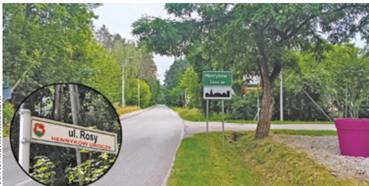
W ramach przedsięwzięcia powstanie ponad 13 kilometrów kanalizacji grawitacyjnej oraz blisko 4 kilometry kanalizacji tłocznej, obsługiwanej przez siedem nowoczesnych przepompowni
