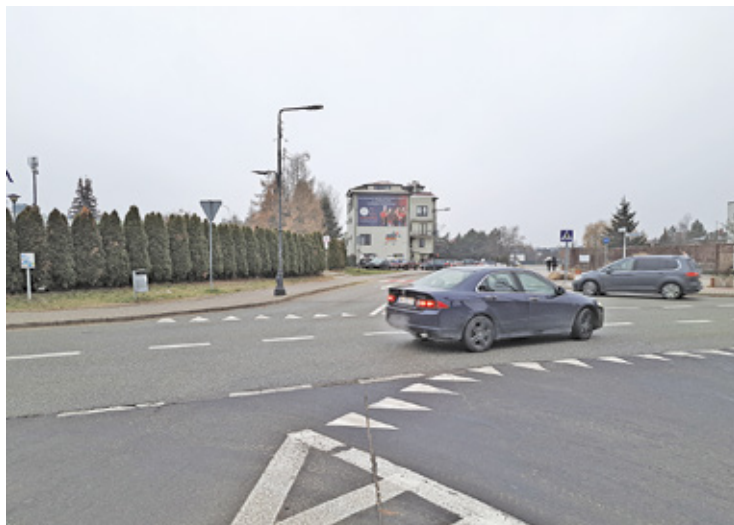
Podczas modernizacji zaplanowano budowę zbiorników retencyjnych po obu stronach ul. Cyraneczki
