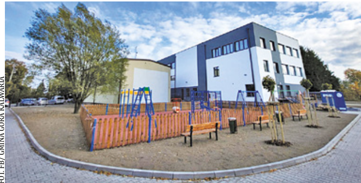
Przedstawiciel firmy odpowiadającej za nową instalację centralnego ogrzewania przyznał, że obecne rozwiązania są niewystarczające dla tak dużej kubatury budynku
