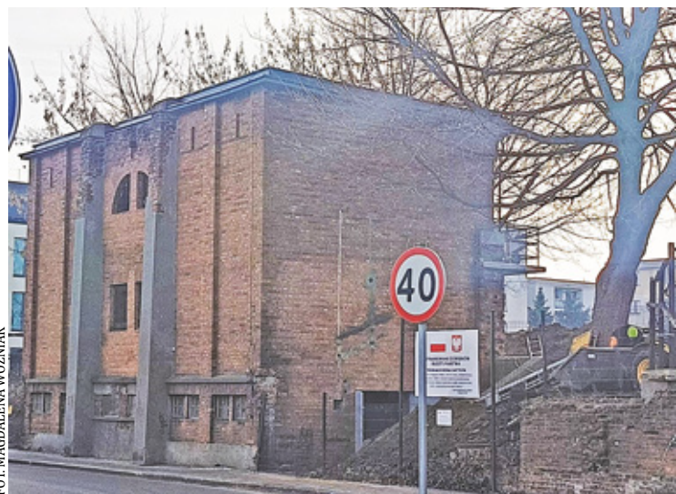
Inwestycja finansowana jest z dotacji Ministerstwa Kultury i Dziedzictwa Narodowego oraz środków gminy. Zakończenie prac planowane jest na połowę tego roku
