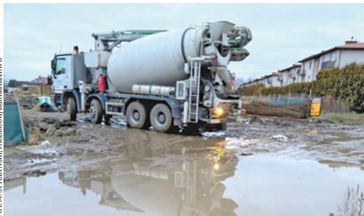
Do połowy tego roku gotowy będzie projekt wraz ze ZRID (Zezwolenie na Realizację Inwestycji Drogowej) dla odcinka ul. Przepiórki od Hiacyntów do Storczykowej (skrzyżowanie z Jastrzębią).
