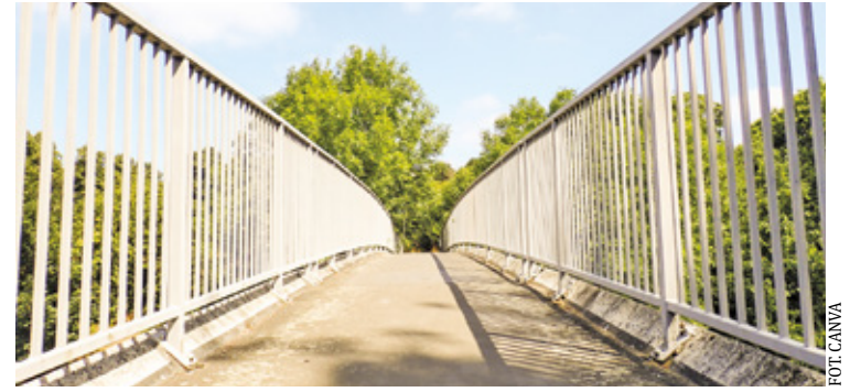
Obecnie piesi korzystają z ul. Pawłowickiej, która ma duże natężenie ruchu, a na części odcinka nie posiada chodnika
