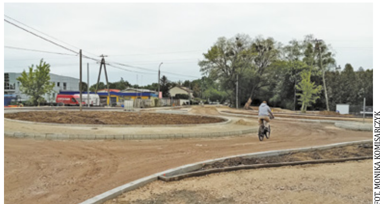
Nowy odcinek drogi połączy ul. Chyliczkowską z ul. Przesmyckiego
