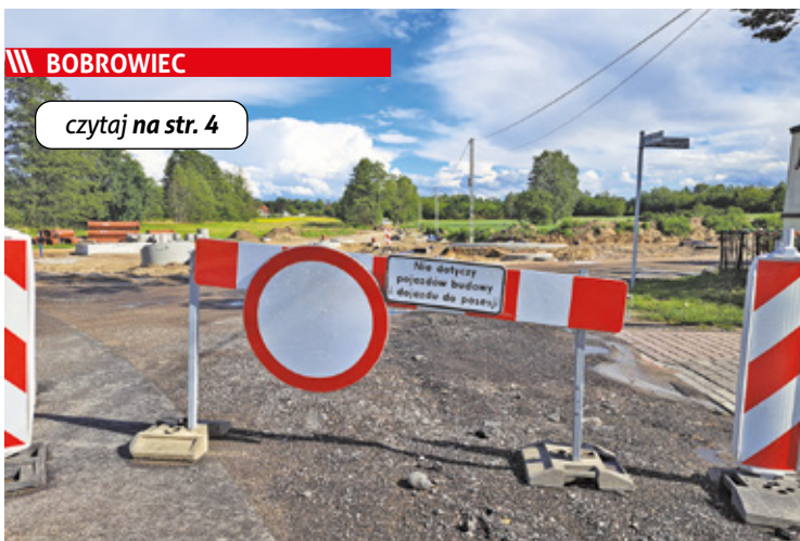
Budowa ronda będzie jednym z kluczowych etapów całej inwestycji
