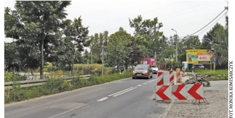
Nowa jezdnia ma mieć podstawowo 6 metrów szerokości, ale w rejonie łuków zostanie poszerzona
