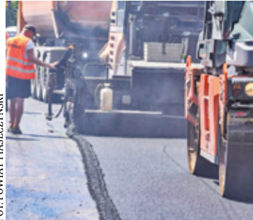
Prace na obu odcinkach potrwać do końca czerwca
