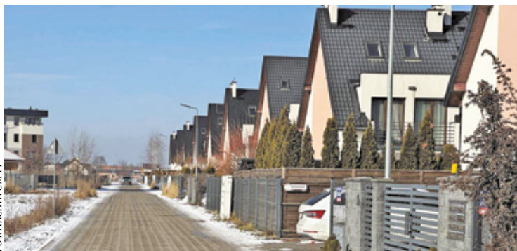
W lutym zeszłego roku gmina poinformowała, że wniosek o dofinansowanie budowy ul. Mieczyków z Rządowego Funduszu Rozwoju Dróg został odrzucony
